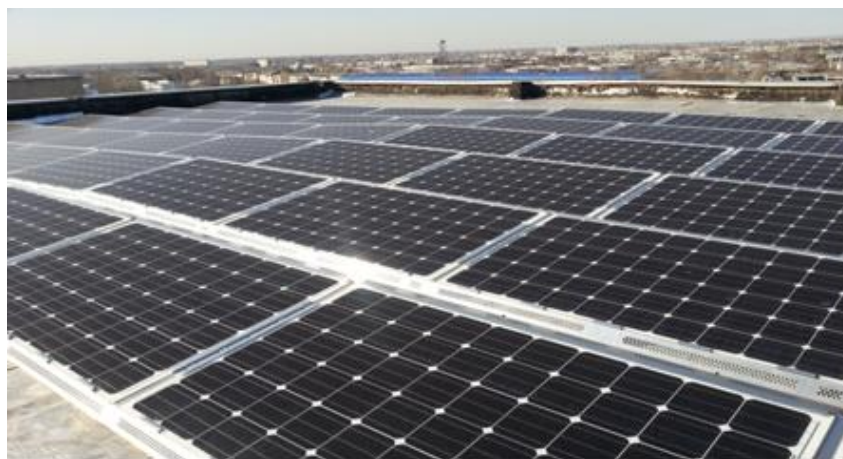
Рис. 1. Общий вид солнечной фотоэлектрической станции мощностью 20 кВт
