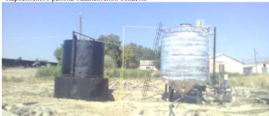
Рис.1. Биогазовая установка в фермерском хозяйстве “Бахт”.
