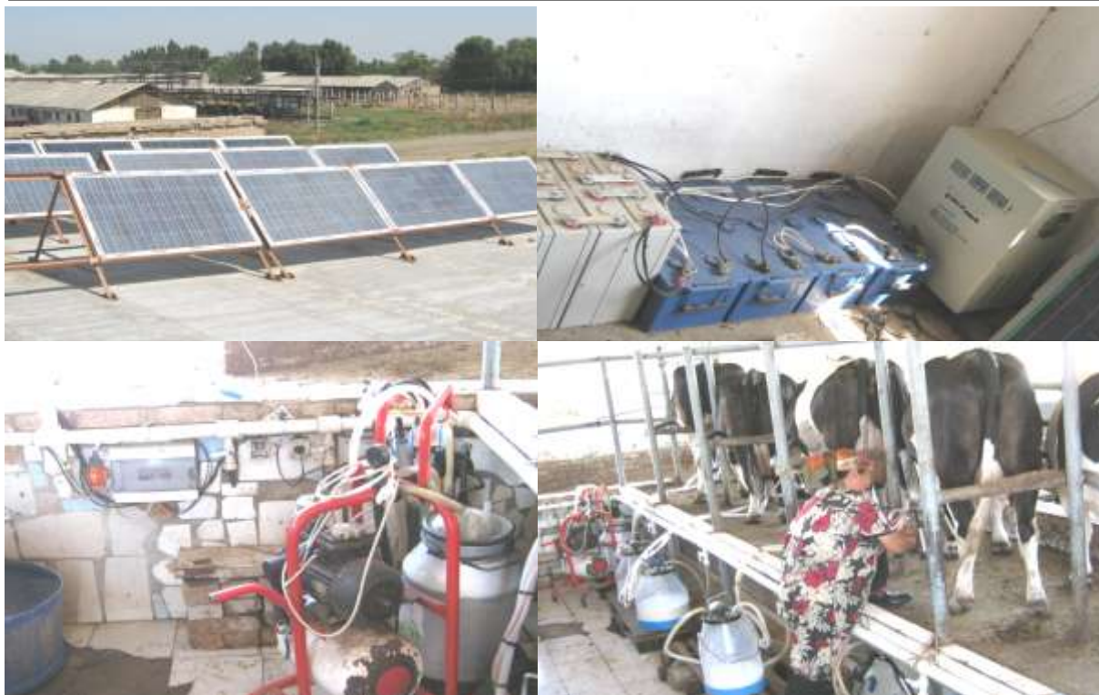
Рис.1. Автономная фотоэлектрическая установка для электропитания доильного цеха животноводческой фермы, справа налево а. наверху - фотоэлектрический блок установки (при испытании использованы 4 из 6 батарей), расположенная на крыше и вид на доильный цех, б. внизу – аккумулялирующая система и инвертор установки, и процесс доения коров в доильном цеху фермы.
