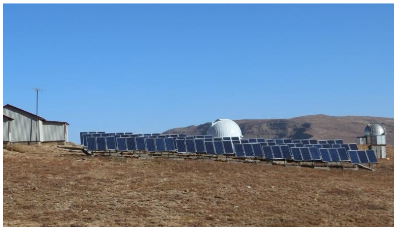
Рис. 1. Общий вид солнечной фотоэлектростанции обсерватории Майданак
