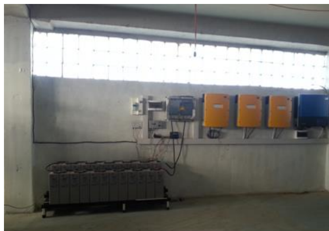
Рис.2. Энергетический блок управления и контроля ФЭС мощностью 20 кВт
