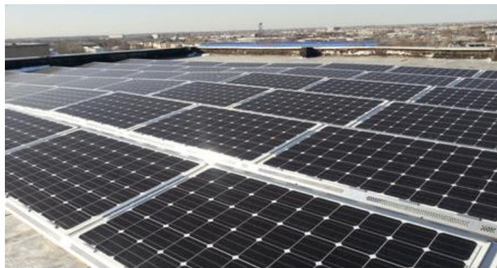
Рис.1. Общий вид солнечной фотоэлектрической станции мощностью 20 кВт
